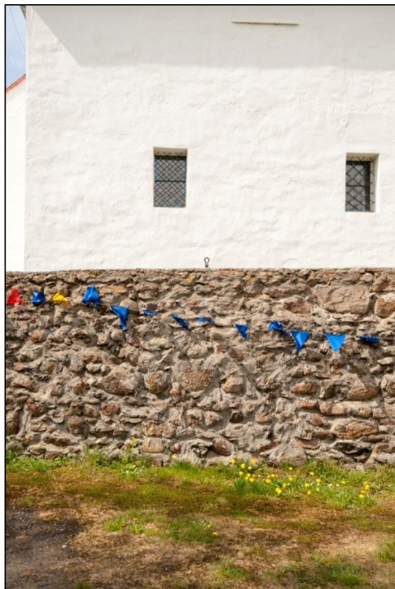
Broniszów Budynek gospodarczy, część dolna z kamienia, górna murowana
