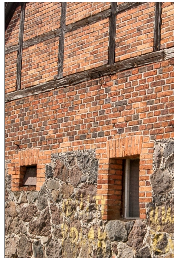
Broniszów Budynek gospodarczy, widoczne łączenia materiałowe i konstrukcyjne
